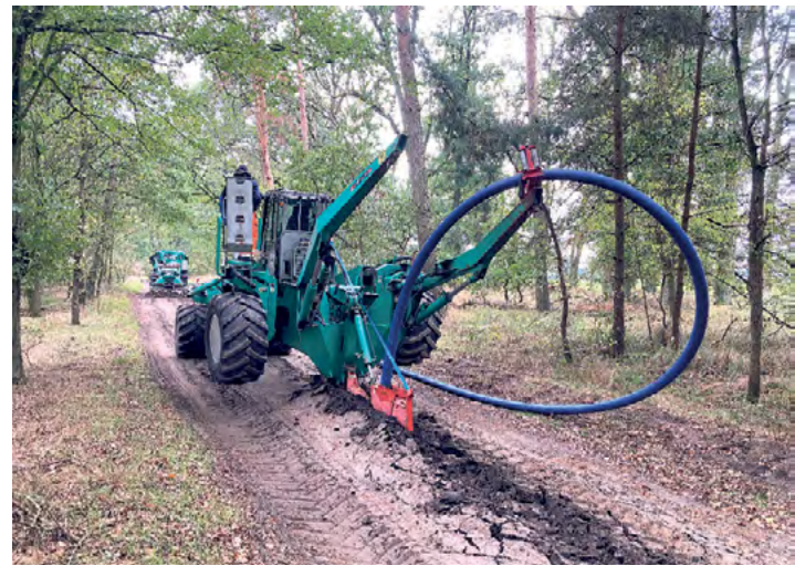
Der WAV „Dosse“ nutzte das Pflugverfahren zum ersten Mal. Baufirma war die Albert Schulz Tiefbau GmbH aus Vielitzsee. Foto: Albert Schulz Tiefbau GmbH
