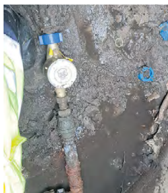
In diesem Schacht liegt der Zähler im Schlamm vergraben.
