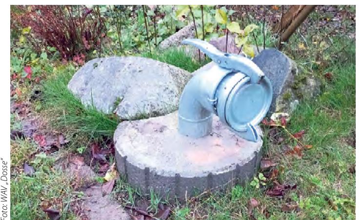
So kann er aussehen, der Saugstutzen für die mobile Entsorgung.
