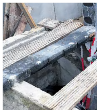
Auch das kommt vor: Der Schacht wurde zugenagelt.
