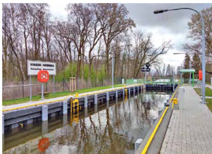
Die Schleuse Hakenberg. Sie wurde von August 2021 bis März 2023 saniert. Intakte Schleusen sind wichtig für die Schiffbarkeit und den Hochwasserschutz.
